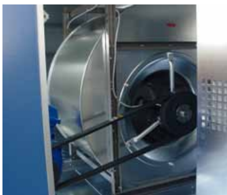
Radial fan with belt drive Radialventilator mit Riementrieb Ventilatore radiale con trasmissione a cinghia
